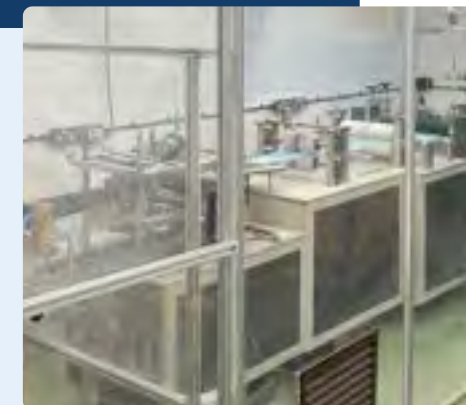
Nuestras instalaciones de producción de salas blancas
